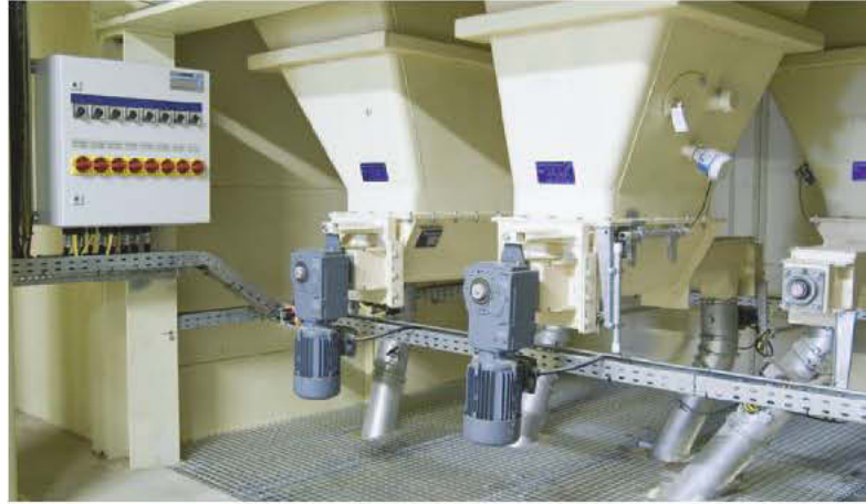
Dosierschnecken | Dosing screw conveyors
