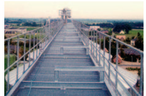
Laufsteg aus feuerverzinkter Stahlkonstruktion mit vollflächig eingelegten Gitterrosten, asymmetrisch angeordnet für die Aufnahme eines Befüllförderers und des Laufweges für Bedienpersonal. Sonderanfertigungen möglich (Foto)
